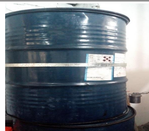
FOTOGRAFÍA 3. TANQUE DE ALMACENAMIENTO DE ACPM
